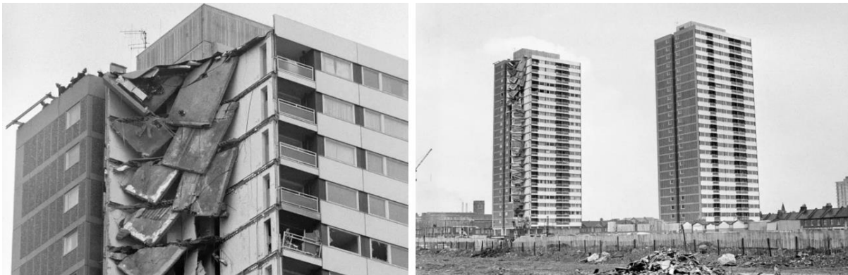
Рис. 1. 16 травня 1968 рік, Лондон, наслідки ефекту прогресуючого обвалення конструкцій житлового будинку після вибуху побутового газу в одній із квартир
